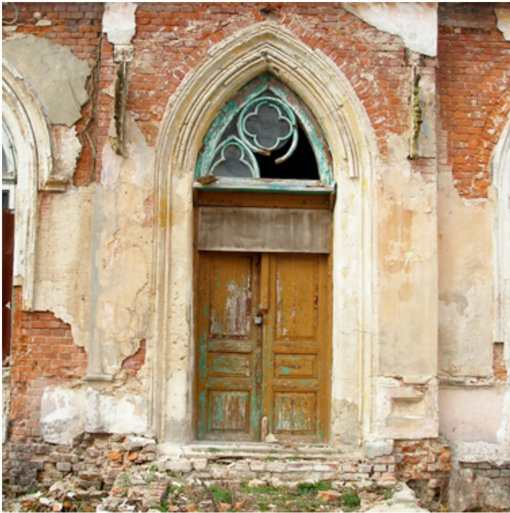
Фото 3. Главный вход. Снимок до сноса здания в 2018 г.
