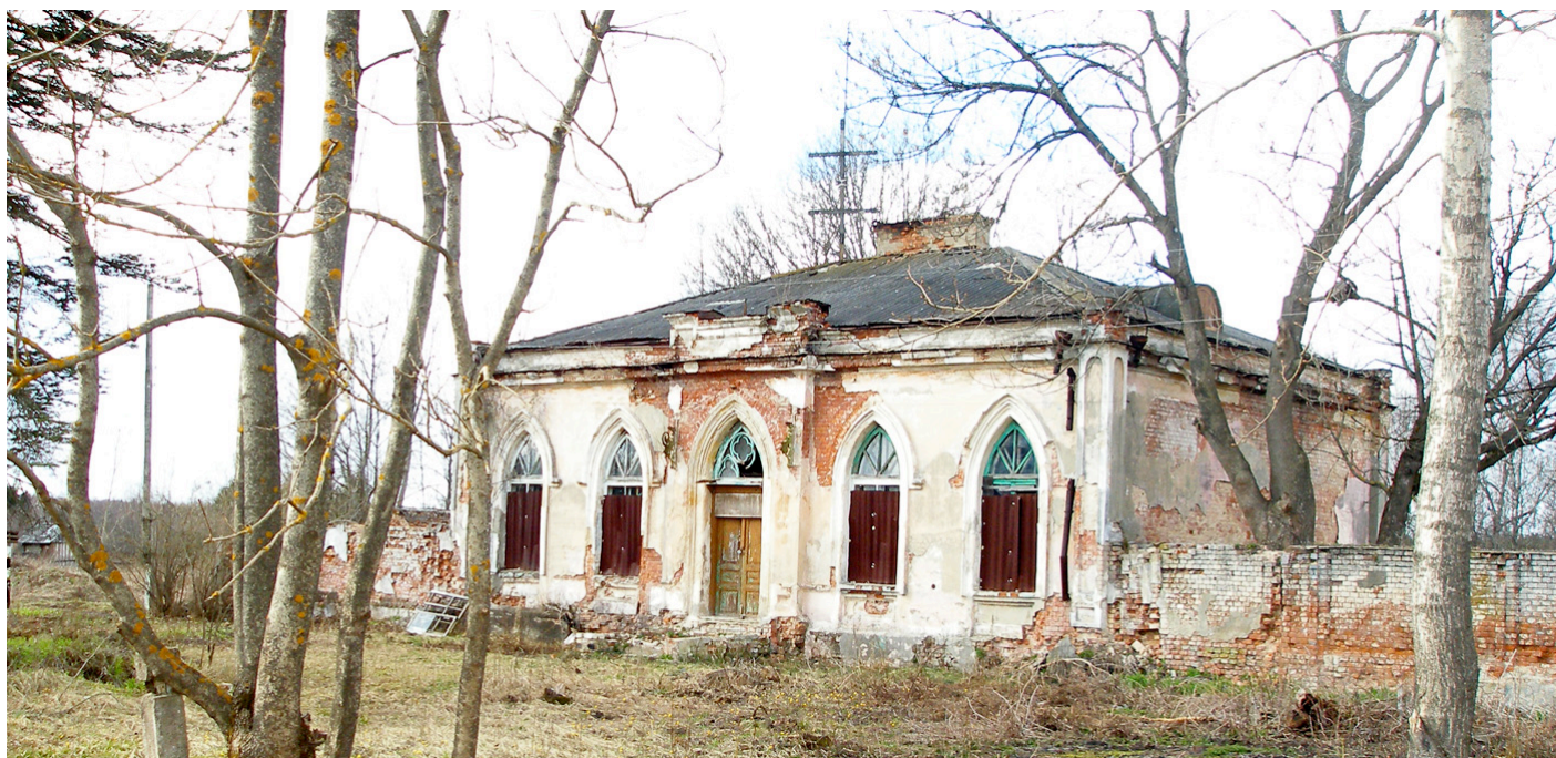
Фото 1. Главный корпус. Вид с востока. Снимок до сноса здания в 2018 г.
