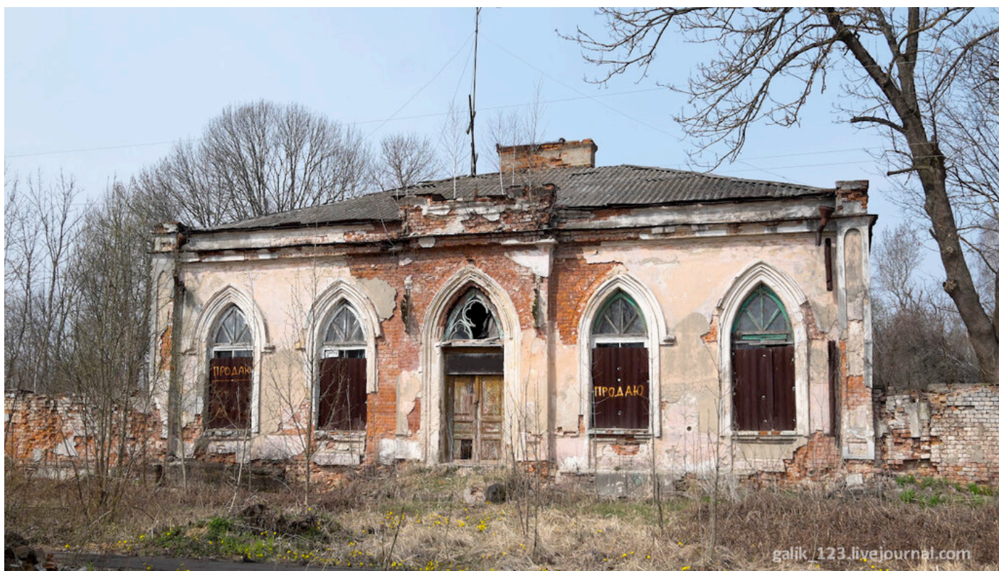
Фото 2. Главный корпус. Вид с юго-востока. Снимок до сноса здания в 2018 г.
