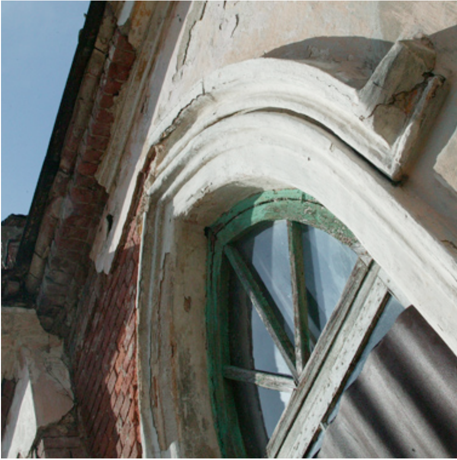
Фото 5. Наличник на главном фасаде. Снимок до сноса здания в 2018 г.
