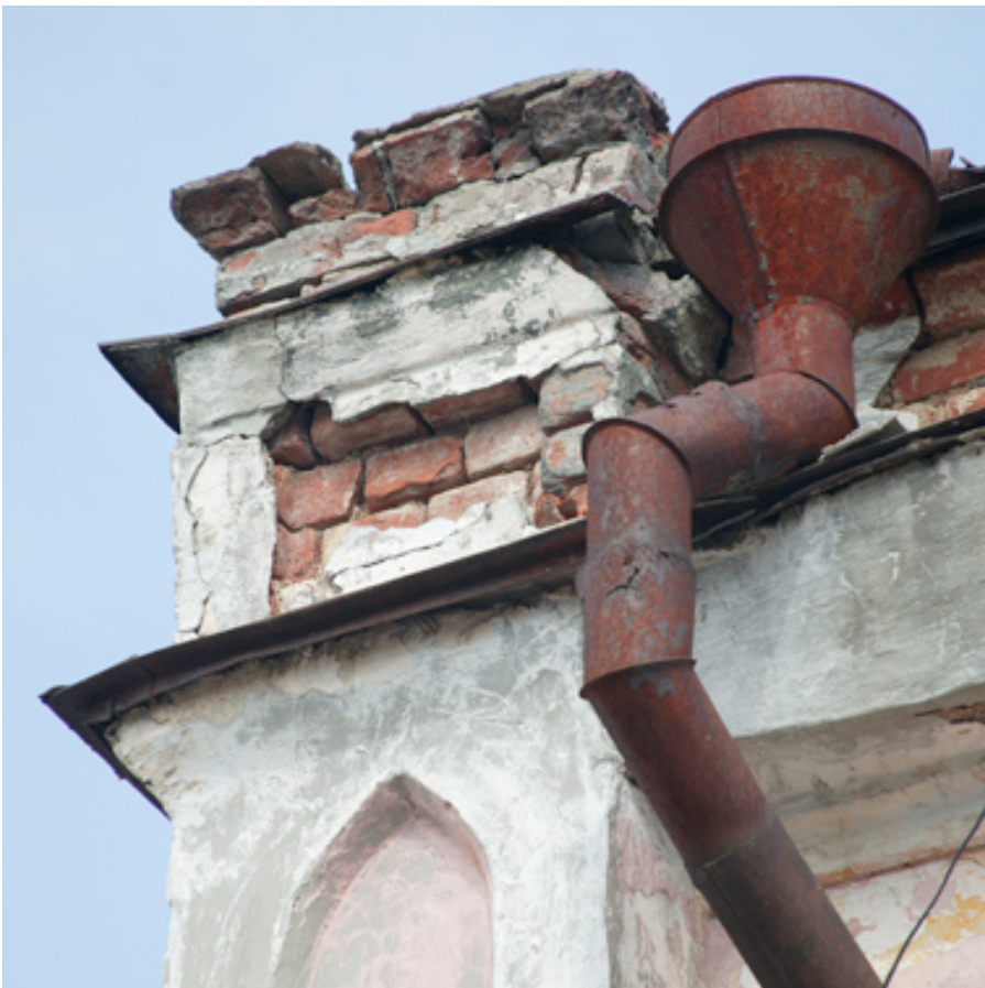
Фото 6. Главный фасад. Завершение фланговой лопатки.
